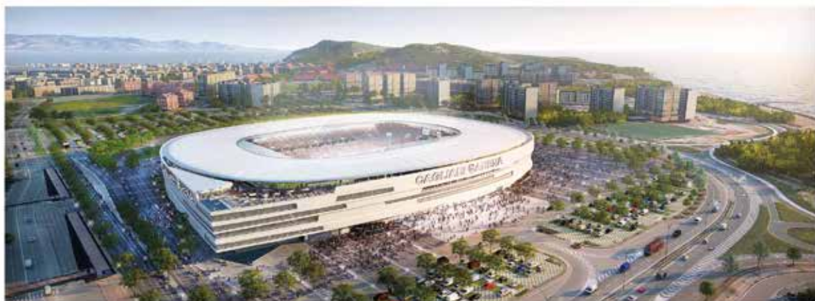
Nuovo Stadio Cagliari Calcio - Cagliari
